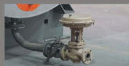
قابلیت نصب شیر اتوماتیک زیرآبزی بصورت تایمردار Automatic Bottom Blowdown Valve
