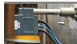
قابلیت نصب سیستم کنترل اتوماتیک T.D.S آب دیگ Automatic T.D.S Control System
